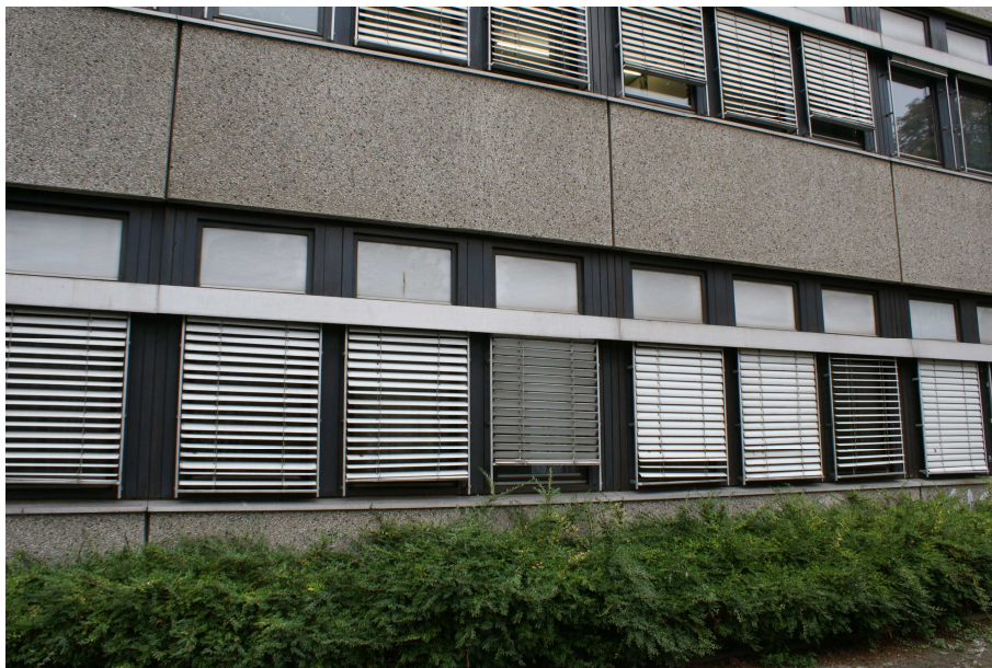
Bild 20: Fugenmassen an der Ostfassade wurden ebenso beprobt.
