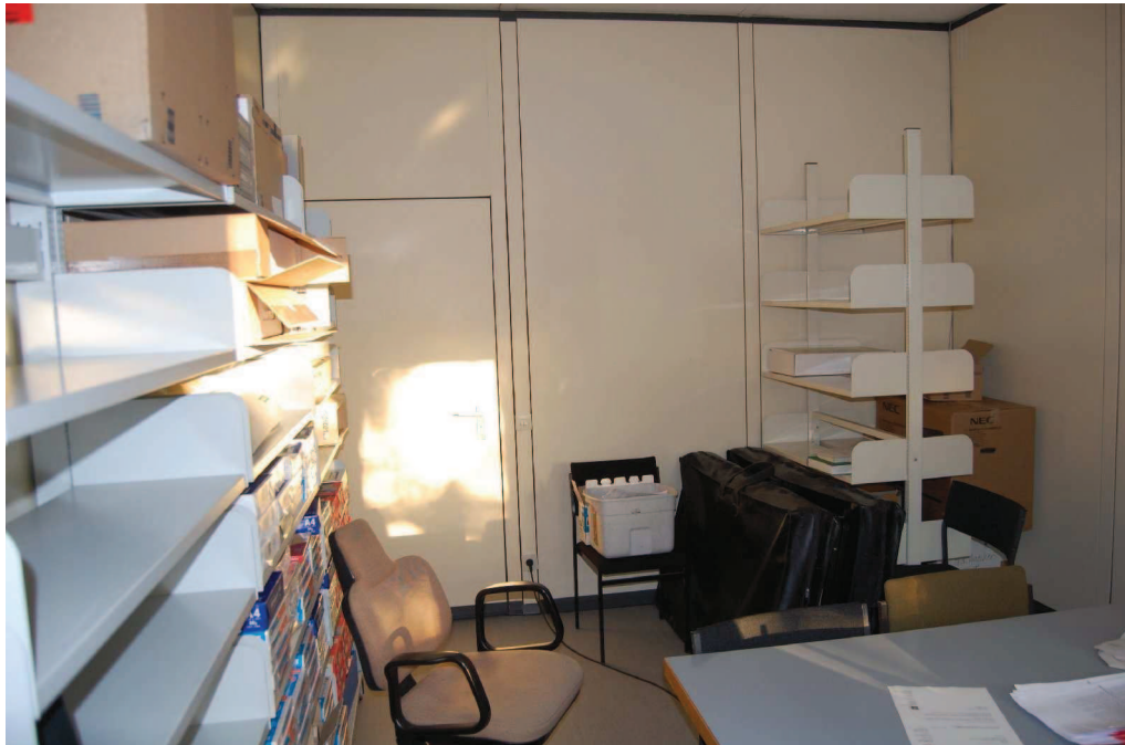
Bild 3/4: Raum 515, Übersichtsaufnahmen, es wurde jeweils eine Messung auf PCP/Lindan, Formaldehyd und PCB (Polychlorierte Biphenyle) durchgeführt.
