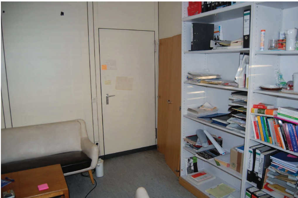
Bild 1/2: Raum 628, Übersichtsaufnahmen, es wurde jeweils eine Messung auf PCP/Lindan, Formaldehyd und PCB (Polychlorierte Biphenyle) durchgeführt.
