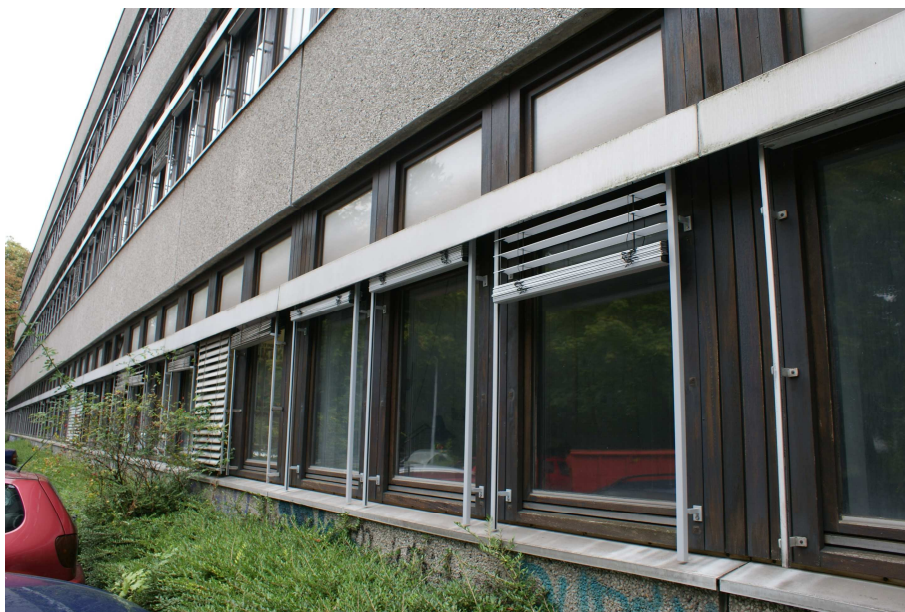
Bild 22: Fugenmassen an der Westfassade wurden ebenso beprobt.
