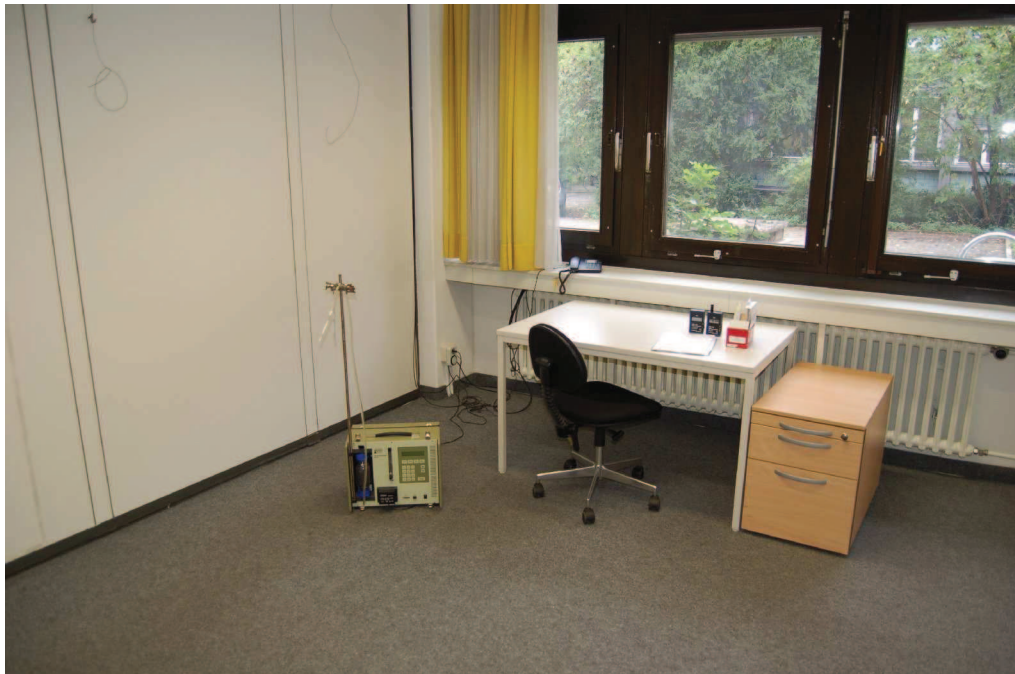
Bild 1/2: Raum 424, Übersichtsaufnahmen, es wurde eine Messung auf PCP/Lindan, Formaldehyd und PCB (Polychlorierte Biphenyle) durchgeführt.
