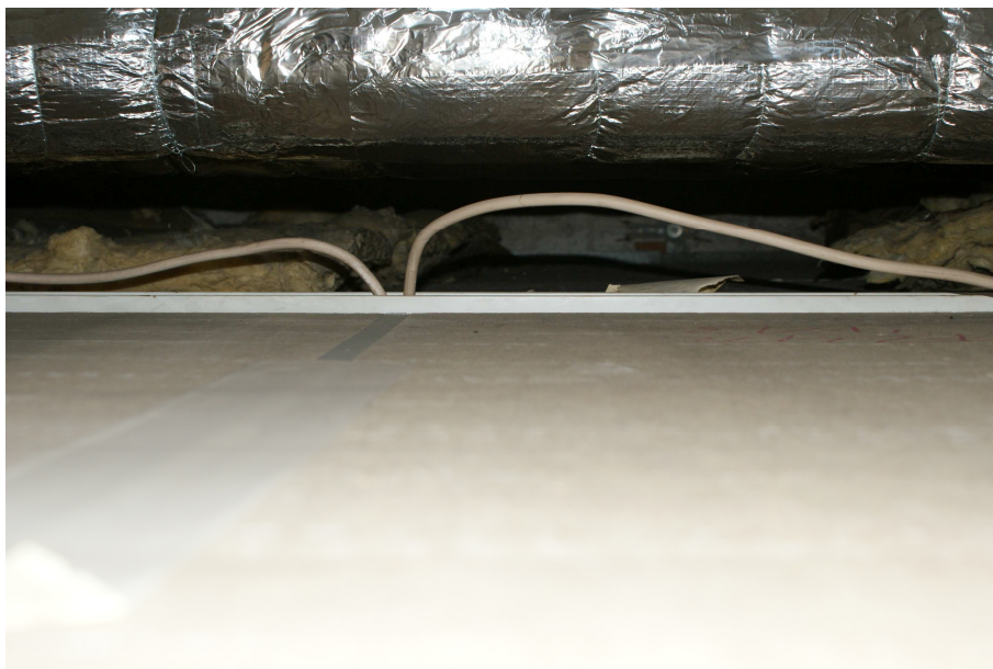
Bild 4: Bei der Inspektion des Zwischendeckenbereichs wurde festgestellt, dass es oberhalb der abgehangten Decke keine Schotts gibt. Dies bedeutet, dass die abgehangten Decken montiert wurden, bevor die Wände aufgestellt wurden.
