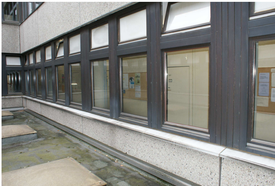
Bild 18: Auch im „Innenhof“ des Gebäudes sind an der Außenfassade Fugenmassen verbaut, die beprobt wurden.
