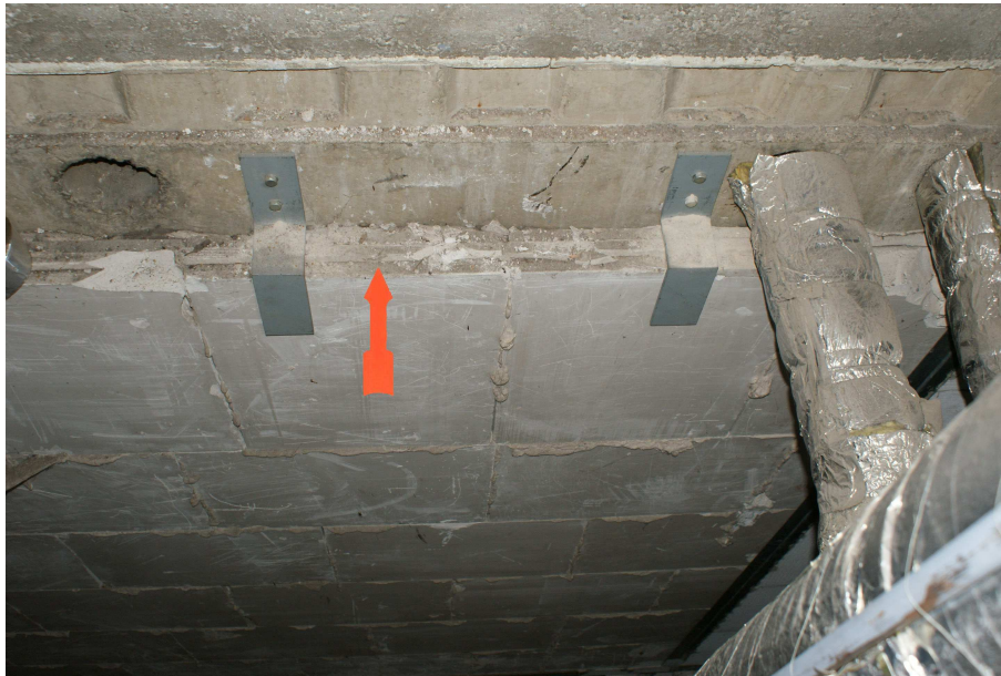
Bild 17: In zwei Schächten neben den Treppenhäusern sind (vermutlich) zum Brandschutz Platten verbaut, die beprobt wurden (MP-216-c-09).
