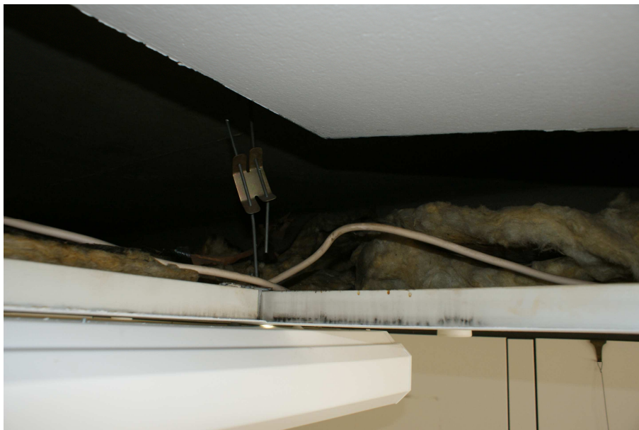
Bild 2: Auf den abgehängten Decken sind in der Regel zusätzlich Matten aus KMF aufgelegt. Die Deckenplatten wurden beprobt (MP-216-c-01).
