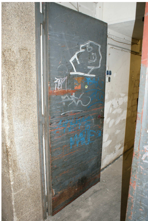
Bild 25: Exemplarische Ansicht einer alten Brandschutztüre.
