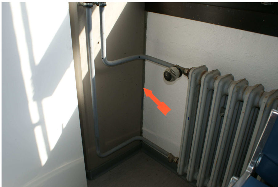
Bild 12: In den Räumen ist elastisches Fugenmaterial verbaut (MP-216-c-06).
