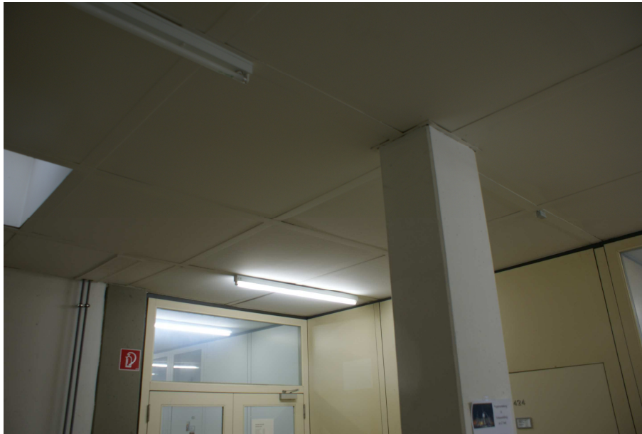
Bild 1: Exemplarische Ansicht des Etagenaufbaus. In der Regel sind Räume und Flure mit einer abgehängten Decke aus KMF-Platten ausgestattet. Die Wände bestehen aus Elementen eines Wandsystems, was im Weiteren näher untersucht wurde.
