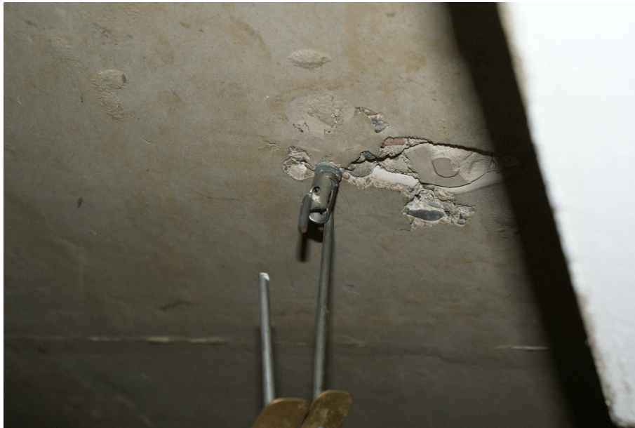
Bild 3: Die abgehangte Decke ist direkt an der Rohbetondecke abgehängt.
