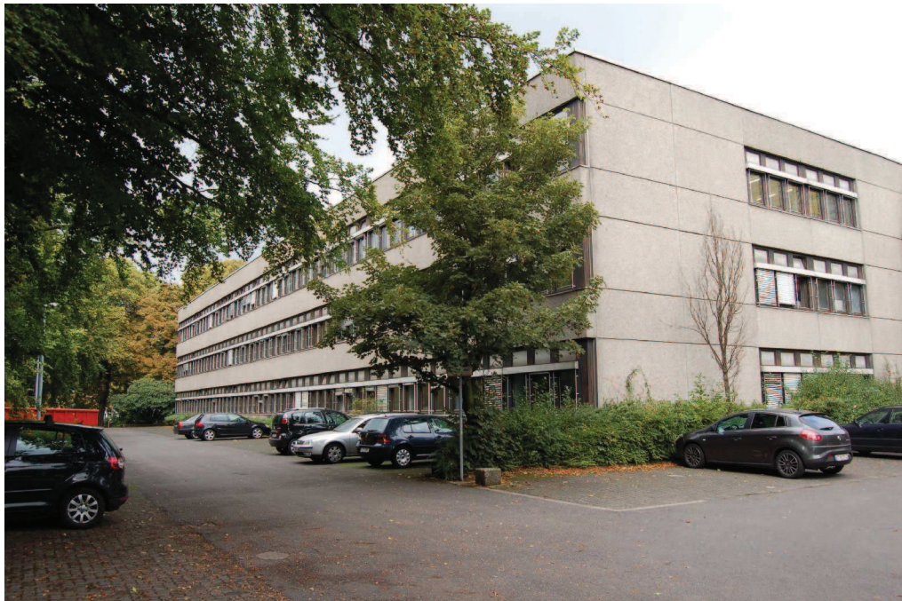
Bild 7/8: Außenansicht des Gebäudes, die Messräume befinden sich im Erdgeschoss (gelber Pfeil).
