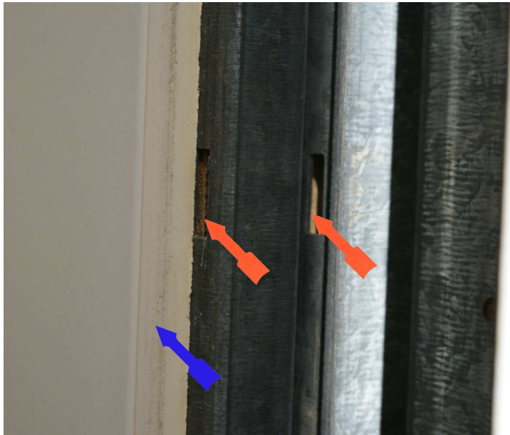
Bild 7: Das Wandsystem besteht aus einer tragenden Metallkonstruktion. Im Inneren sind zwei Holzplatten verbaut (orange Pfeile, MP-216-c-02), Außen sind beidseitig beschichtete Holzplatten aufgebracht (MP-216-c-03).
