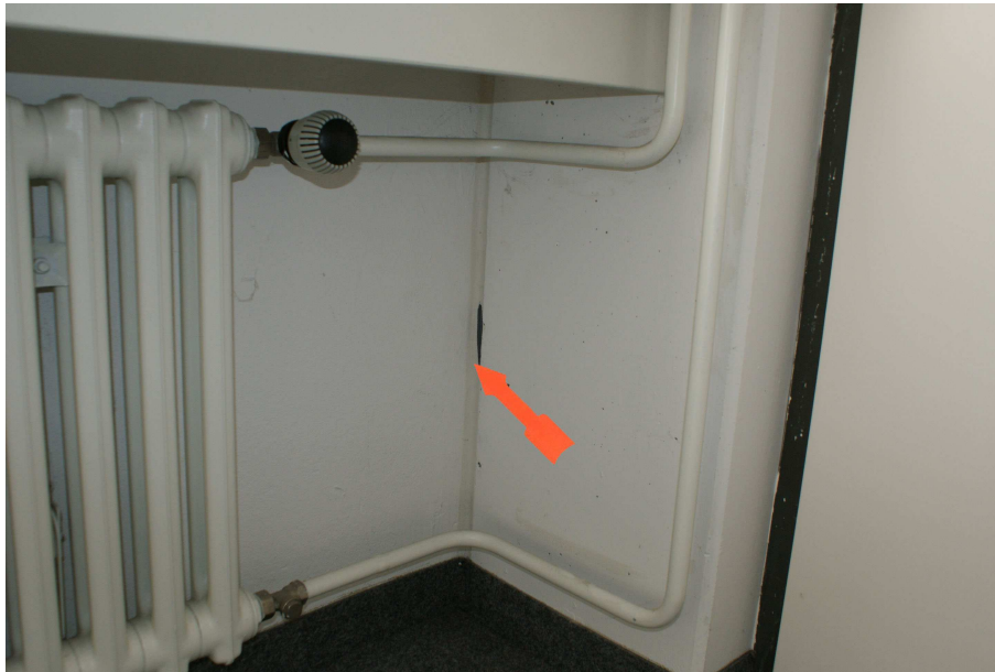
Bild 11: In den Räumen ist elastisches Fugenmaterial verbaut (MP-216-c-05).
