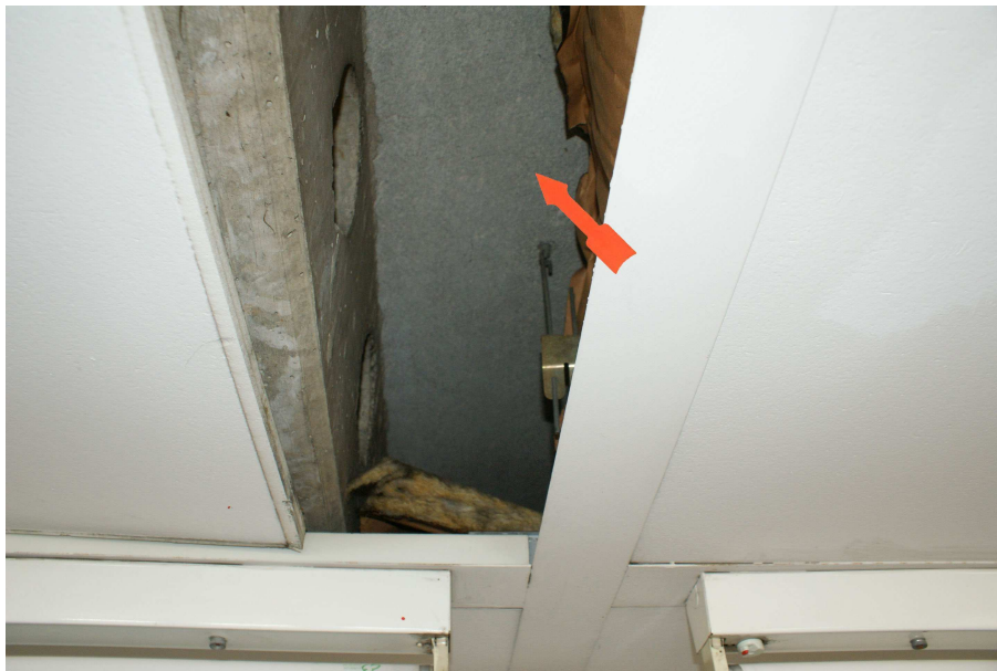
Bild 8: Vereinzelt sind unter der Rohbetondecke Faserzementplatten verbaut (MP-216-c-04).
