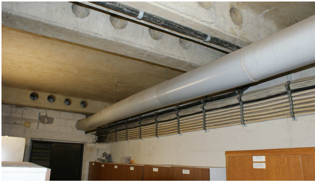
Bild 9: Im Kellergeschoss sind diese Faserzementplatten zwischen den Rippen der einzelnen Deckenfragmente deutlich zu sehen.
