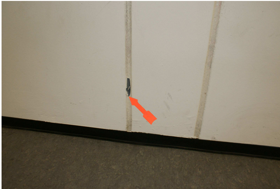
Bild 13: Auch in den Fluren ist elastisches Fugenmaterial verbaut (MP-216-c-07), was ebenfalls beprobt wurde.
