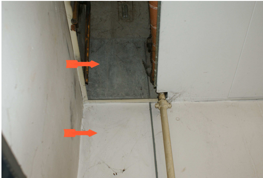
Bild 15: Die Faserzementplatten sind unterhalb der Decke mit Farbe beschichtet, im Zwischendeckenbereich hingegen unbeschichtete.
