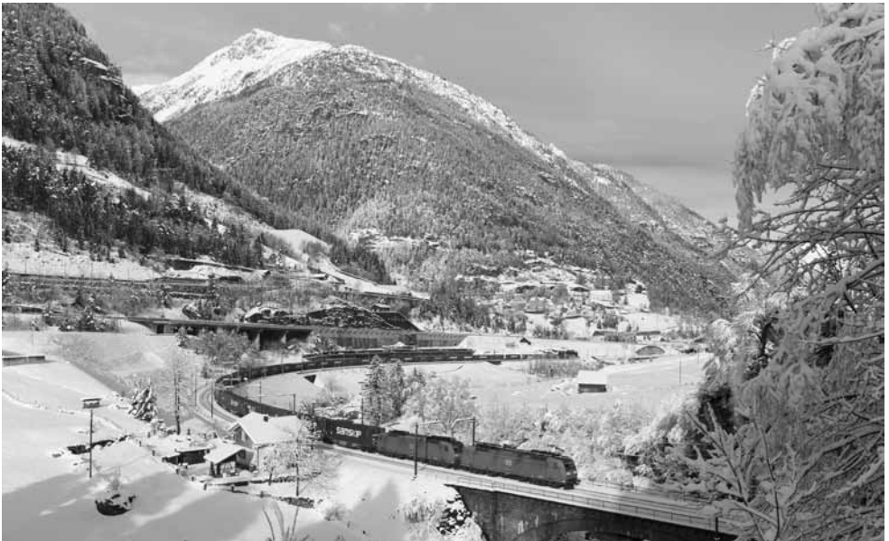
Zwei DB Schenker-Lokomotiven ziehen einen Containerzug durch die Kehren von Wassen, Schweiz. (David Gubler/wikicommons)
