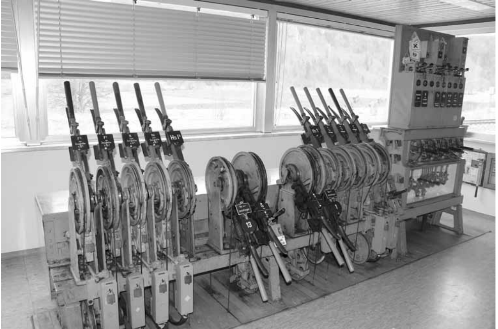
Mechanisches Stellwerk in Hausen im Tal im Jahr 2018. (Olga Ernst und Hp. Baumeler/wikicommons)
